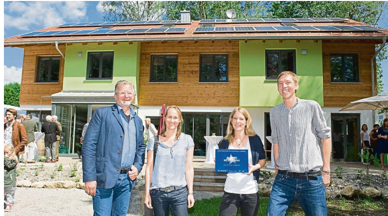
Im November 2014 wurde mit dem Bau des „Haus südSee“ begonnen, 2015 wurde es bezogen, und gestern war Einweihung. Der Bau wird vor allem über Erdwärme-Pumpen beheizt. Im Bild (v.l.) Manfred Fent, Sabine Demmel von der Aktion „Sternstunden“, die 400 000 Euro spendete, sowie die „südSee“-Mitarbeiter Alexandra Windisch und Hans Wagner. sko
